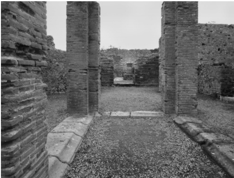
98. View toward the tablinum (G) and mill yard (L) from the atrium (B), House of the Baker (VI.3.3, 27), Pompeii. Photo: authors (su concessione del Ministero per i Beni e le Attività Culturali – Soprintendenza Speciale per i Beni Archeologici di Napoli e Pompei).
