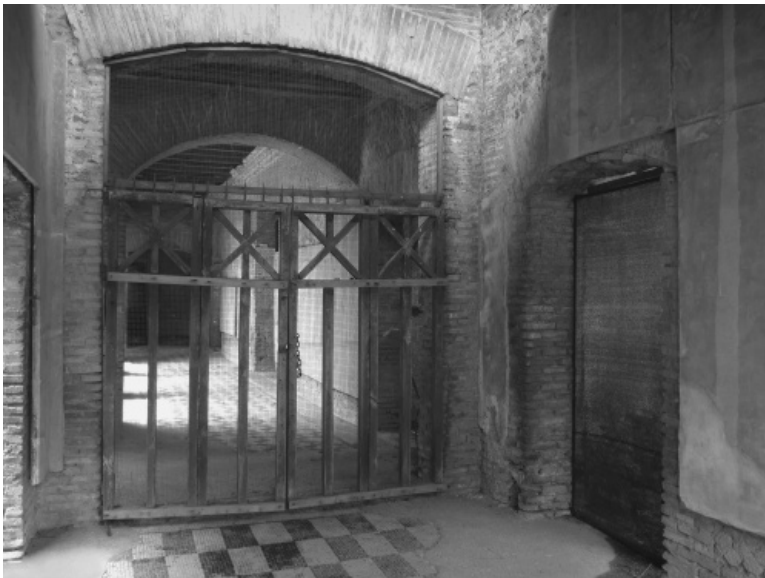
28. Door to the kitchen (3), at right, from the house entrance toward the central peristyle, House of the Muses (III.9.22), Ostia. Photo: authors (su concessione del Ministero per i Beni e le Attività Culturali – Soprintendenza Speciale per i Beni Archeologici di Roma).
