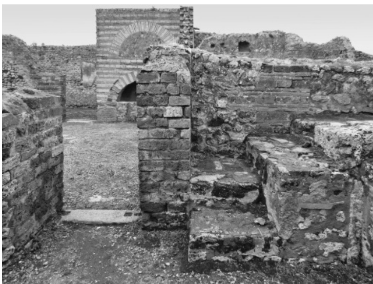
102. Kitchen (N) with stairs to an upper floor, House of the Baker (VI.3.3, 27), Pompeii. Photo: authors (su concessione del Ministero per i Beni e le Attività Culturali – Soprintendenza Speciale per i Beni Archeologici di Napoli e Pompei).
