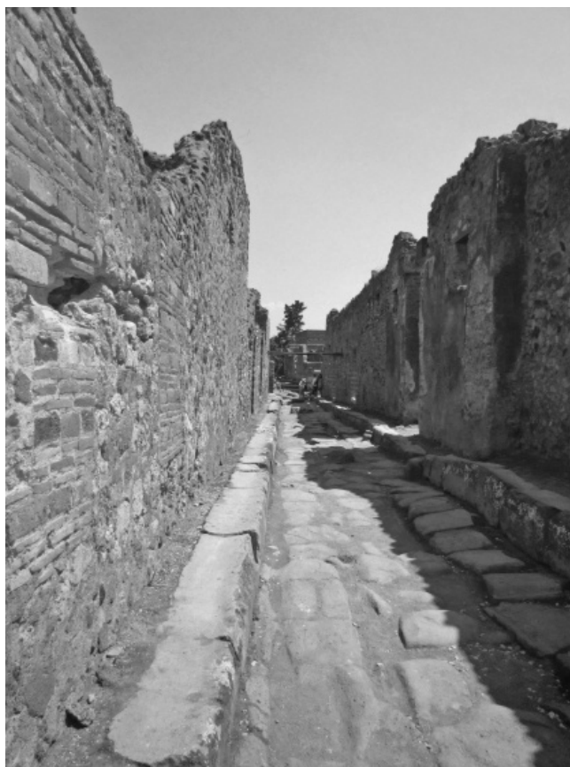
79. View of Vicolo di Mercurio, from east of the House of the Vettii (VI.15.1, 27) to Via del Vesuvio, Pompeii. Photo: authors (su concessione del Ministero per i Beni e le Attività Culturali – Soprintendenza Speciale per i Beni Archeologici di Napoli e Pompei).
